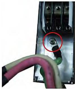
6. 把其余导线的 R 型端子接到端子上，并用扭矩螺丝刀拧紧每个端子的固定螺丝。扭矩大小视螺丝尺寸而定。
